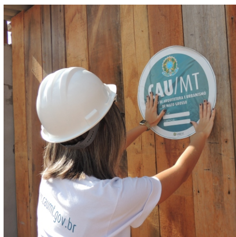
Ações de fiscalização e orientação em obras
