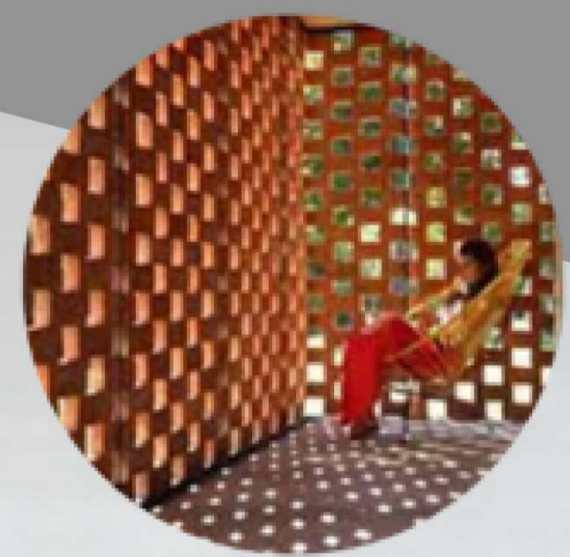
Cobogós de Tijolinho Maciço
